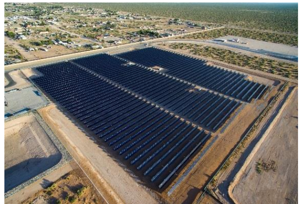
Instalación Community Solar Texas en el este de El Paso
